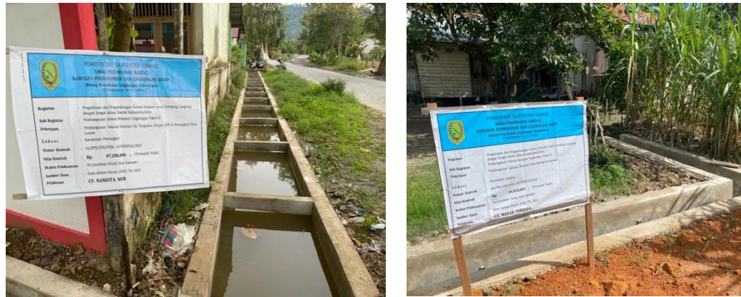
Gambar II.3. Pembangunan Saluran Drainase/Gorong-Gorong
