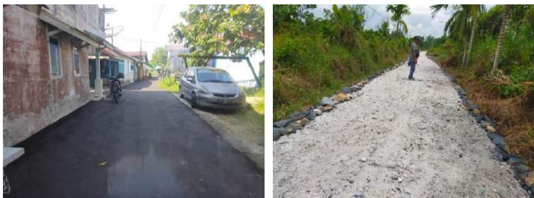
Gambar III.4. Jalan Lingkungan yang dibangun pada PSU Perumahan
