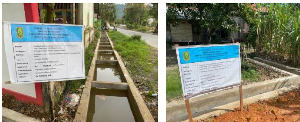
Gambar III.1. Pembangunan Saluran Drainase/Gorong-Gorong
